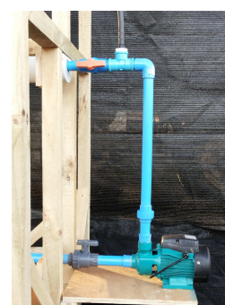
Succión e impulsión de agua para sistema de riego
