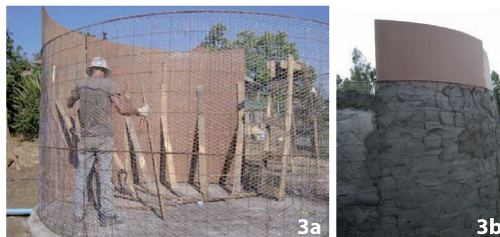
Foto 3. (3a y 3b). Instalación del cimbrado para el revestimiento de la cisterna y aplicación de la primera mano de mezcla de arena y cemento exterior.
