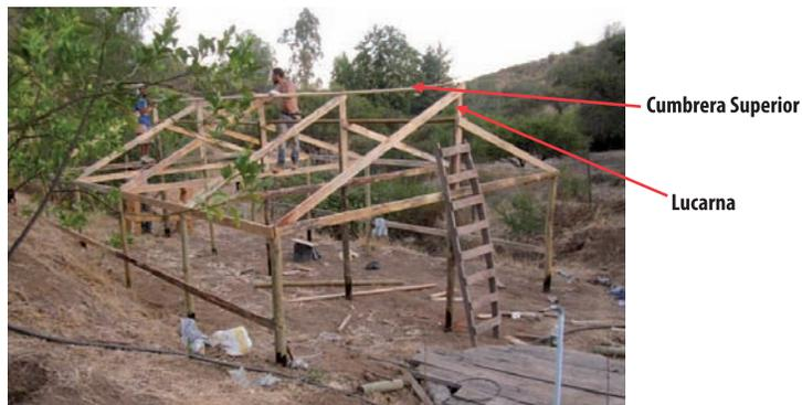
Foto 3. Colocación de vigas y cumberas.
