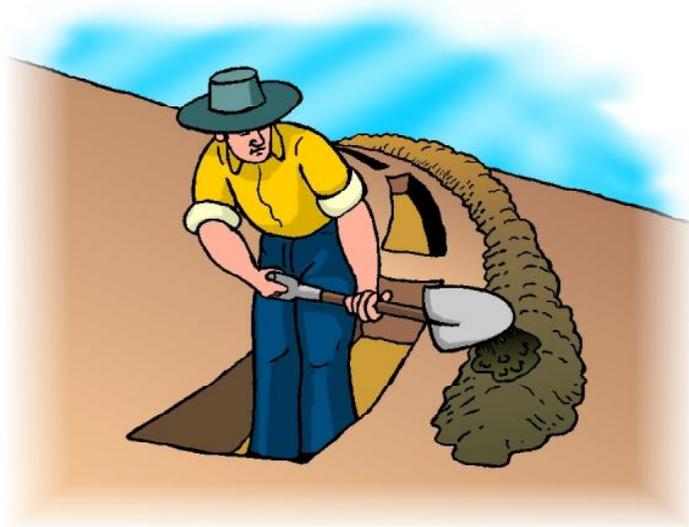
**Figura 3.** Depositando la tierra en la parte baja de la zanja, a unos 30 centímetros de distancia del borde de la zanja.
