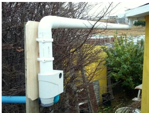
**Figura 2.** Filtro de polietileno para retener impurezas de mayor tamaño, como hojas e insectos.
