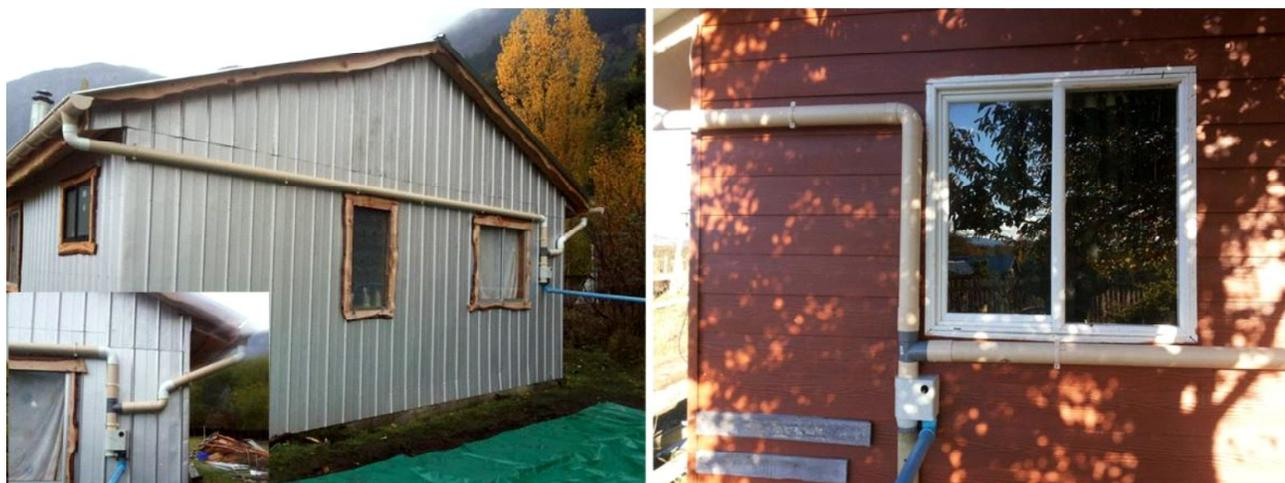
**Figura 1.** Diseños de conexión de dos aguas a través de Tee sanitaria de 75 mm.
