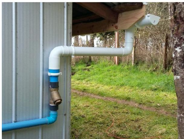
**Figura 3.** Filtro con cuerpo de bronce utilizado para retención de partículas pequeñas.
