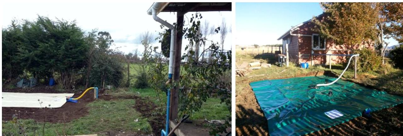
**Figura 4.** Izquierda: Instalación de cisterna flexible con entrada lateral y filtro de bronce. Derecha: Instalación de cisterna flexible con entrada superior y filtro de polietileno.
