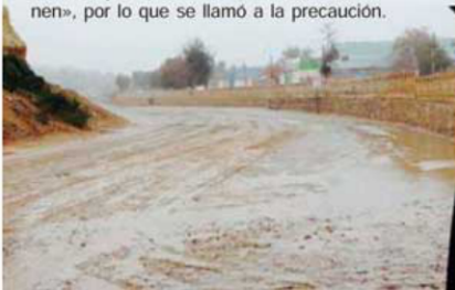
Los caminos cubierto con la pasta conocida como vischofita que es tierra mezclada con sal, quedan como jabón con un poco de agua.
